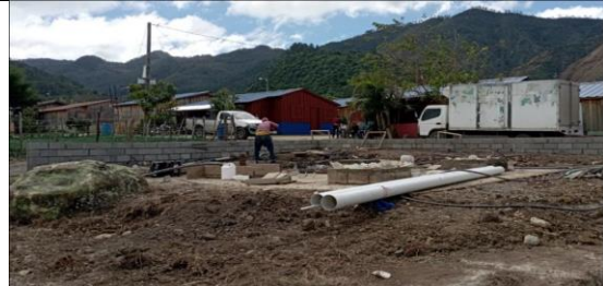
Restauración PTAR Villa Poppy
